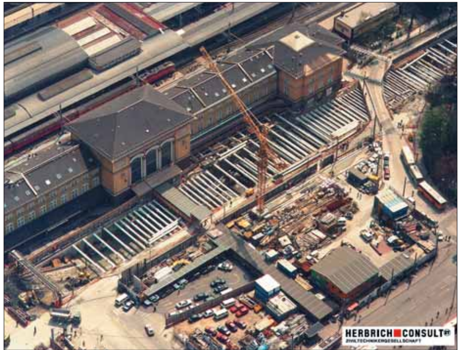
Die Baugrube des unterirdischen Lokalbahnhofes vor dem Empfangsgebäude des Salzburger Hauptbahnhofes
