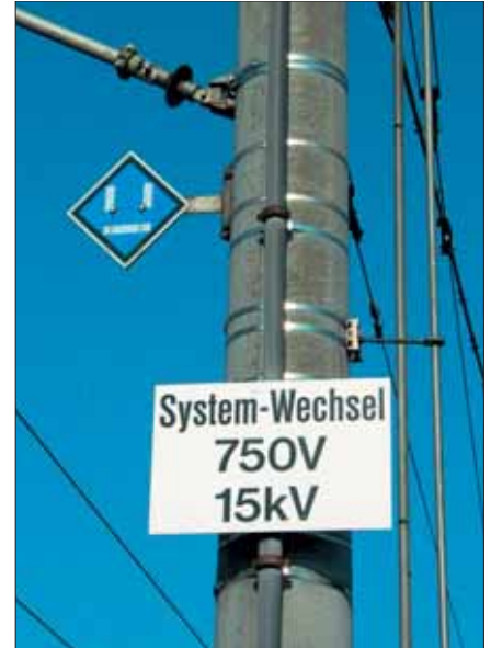
Beschilderung eines Systemwechsels auf der Strecke Foto: AVG
