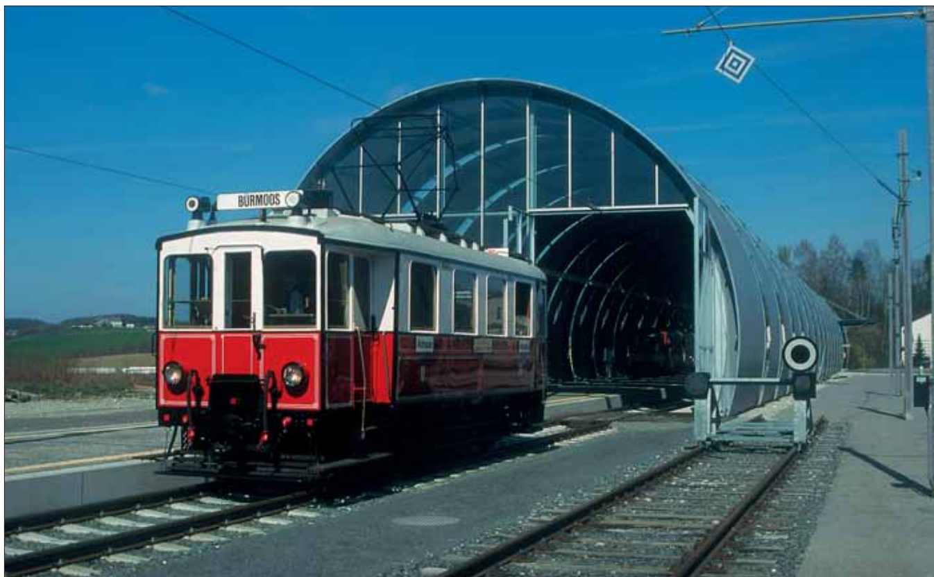
Mit Unterstützung des Landes Oberösterreich errichtet: Der neue Endbahnhof der Salzburger Lokalbahn in Trimelkam Foto: R. FUCHS
