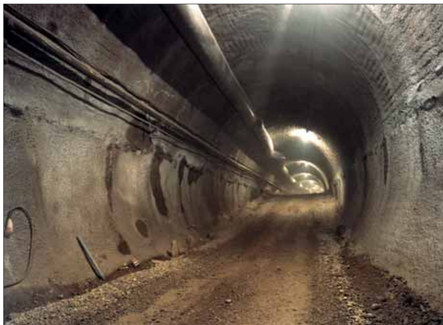
U-Bahn München: Tunnelherstellung nach der neuen österreichischen Tunnelbauweise NÖT
