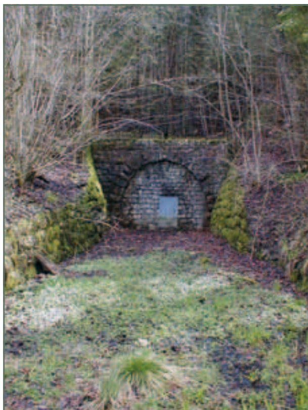
Zugemauertes Nordportal des Kalvarienbergtunnels als Vergleich zum Bild auf Seite 35 unten. (Foto: Markus Müller, Frühjahr 2001)
